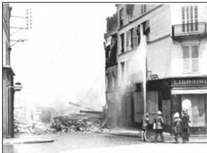
Incendie de la rue Solferino Photo Hutin
